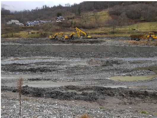
Travaux de dégravement au niveau de l'arrivée d'eau
